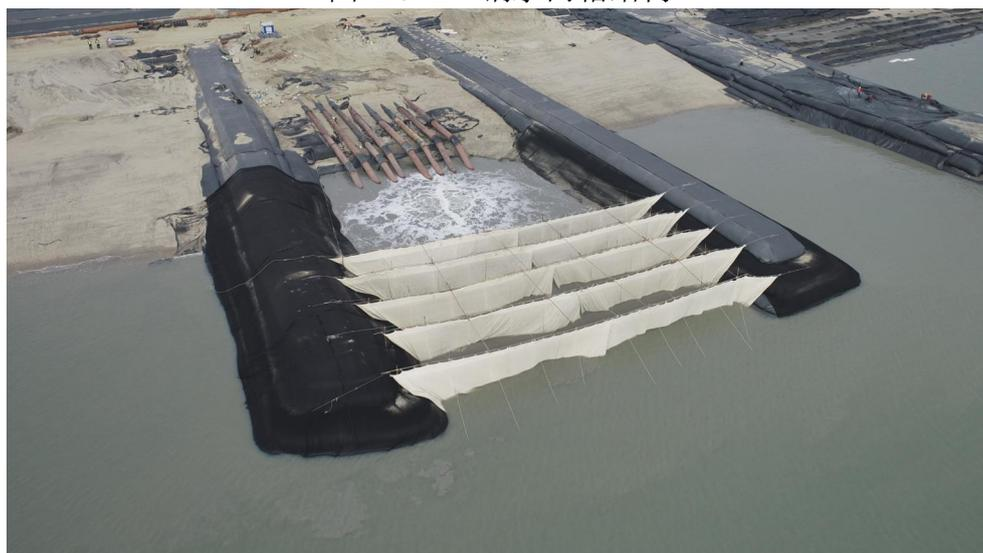
图 2.5-3 溢流管末端土工布
