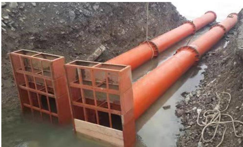
图 2.5-2 钢水门箱结构
